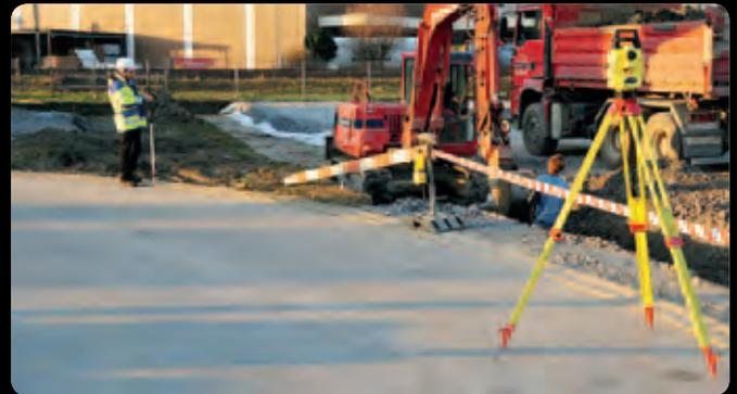
Leica iCON robot 50 es un instrumento versátil que le permite cubrir todas las tareas de la obra. Captura de datos, verificaciones, replanteos y control de maquinaria pueden realizarse de manera rápida y sencilla.
